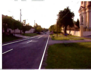
Пресвучен асфалтом већи део пута Главне улице
