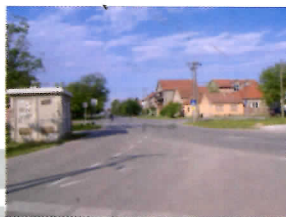
Реконструкција и проширење раскрснице на уласку у индустријску зону у улици Николе Тесле
