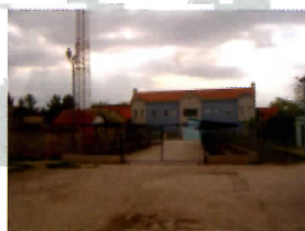
Изграђена зелена пијаца
