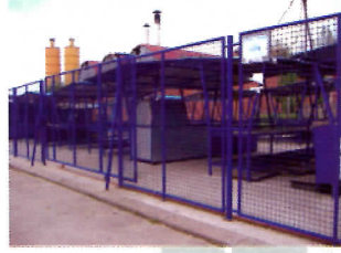
Изграђена зелена пијаца
