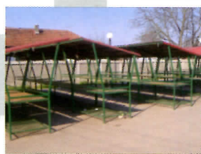
Изграђена зелена пијаца
