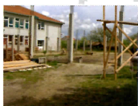
Изградња спортске-школске хале у току
