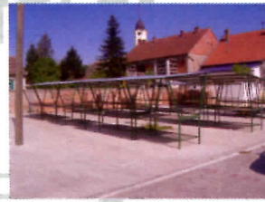
Изграђена зелена пијаца
