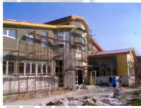
Изградња обданишта у подмаклој фази
