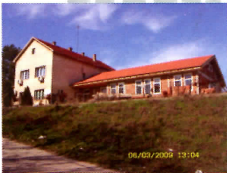
Реконструкција и доградња дома здравља
