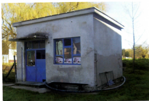
...реконструисана је кућица за воду, омалтерисани оштећени делови.
