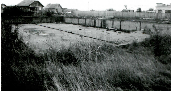
Општинску власи не интересује завршетак Олимпијског базена
