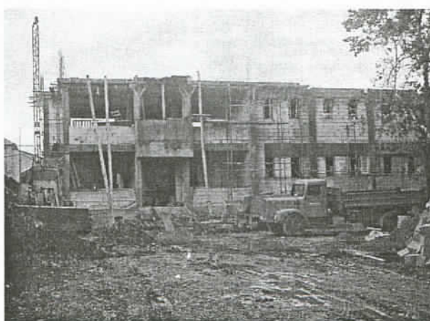
Радови на изградњи историјског архива
