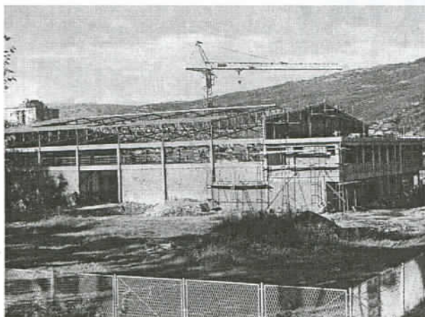
Радови на изградњи спорћске хале
