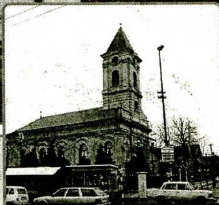
На цркви Вазнесења Господњег извршили смо неопходне поправке
