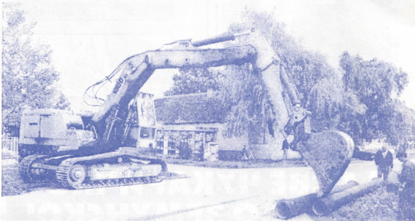
Изградња водоводне и канализационе мреже и гасификација насеља
