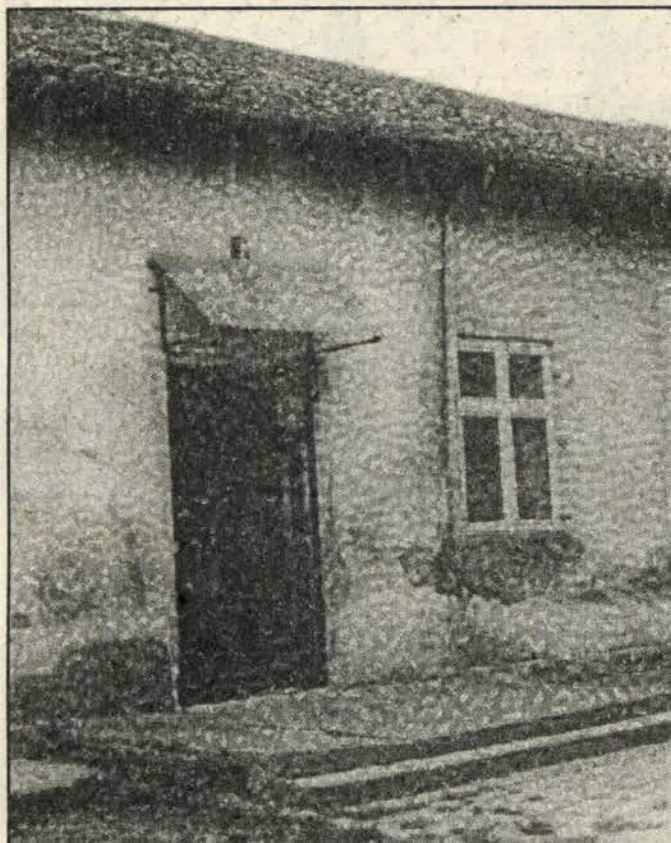
Општина Земун је на Основној школи „22. октобар“ заменила прозоре, поправила подове и окречила учионице
