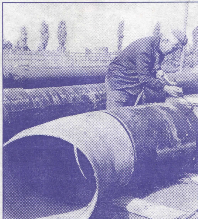
Вода у свако домаћинство: изградња и реконструкција водоводне мреже
