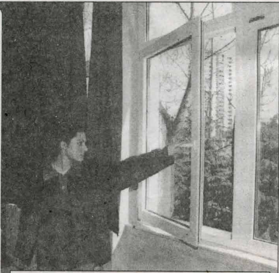
На основној школи „Раде Кончар“ замењени су прозори, подови и керамичке плочице. Поправљени су мокри чворови и све учионице су окречене
