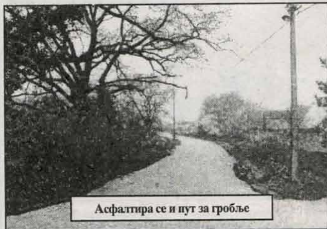
После постављања дренажног слоја почиње асфалтирање улице Живка Чобановића
