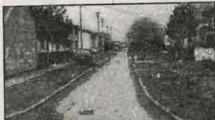
Асфалтирани део Пинкијеве улице, радови се настављају
