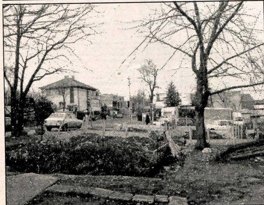
Темељ будућег бесправног објекта у Кумодрашкој улици
