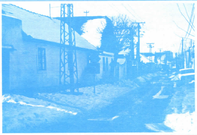
Да ли нас и ове зиме очекују овакве улице? Ужи центар града без канализације и водовода.
