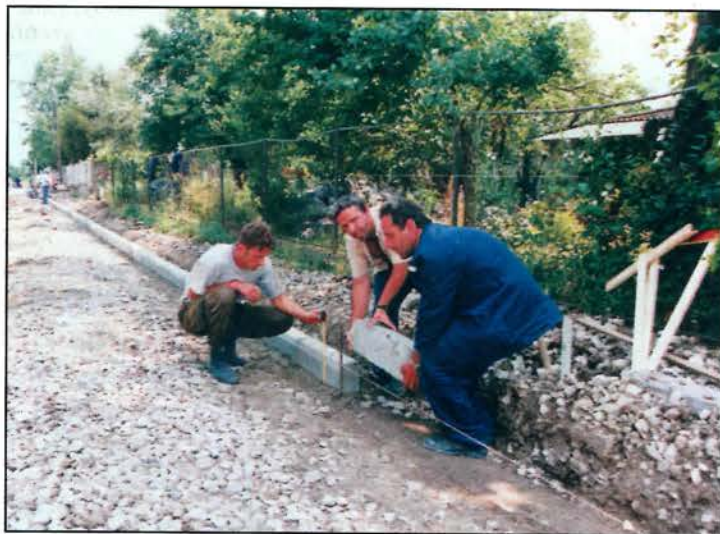
Батајница - изградња и реконструкција улица
